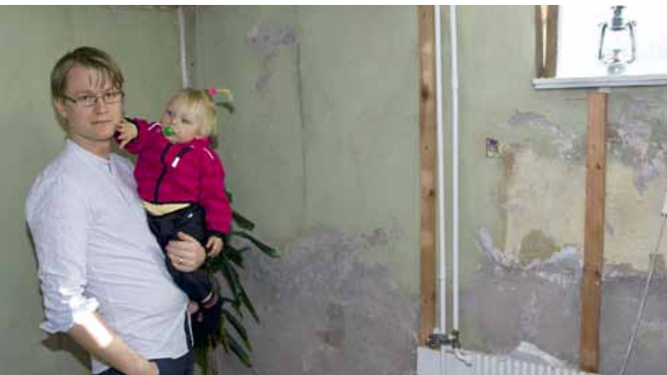
Bakom källarens tidigare träpanel frodades möglet. Nu är panelen bort-riven och muren har behandlats och torkats inför källarenoveringen.
